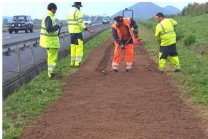
Figure 30 : Les finitions pour l'égalisation du lit de semences ont été réalisées à la main.
