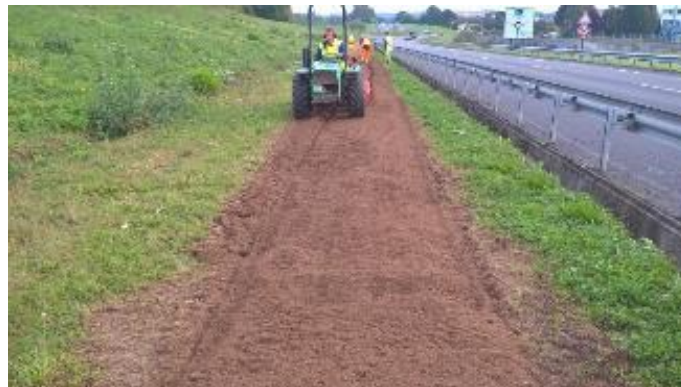
Figure 29 : La préparation du lit de semence est réalisée de manière mécanique dans un premier temps.
